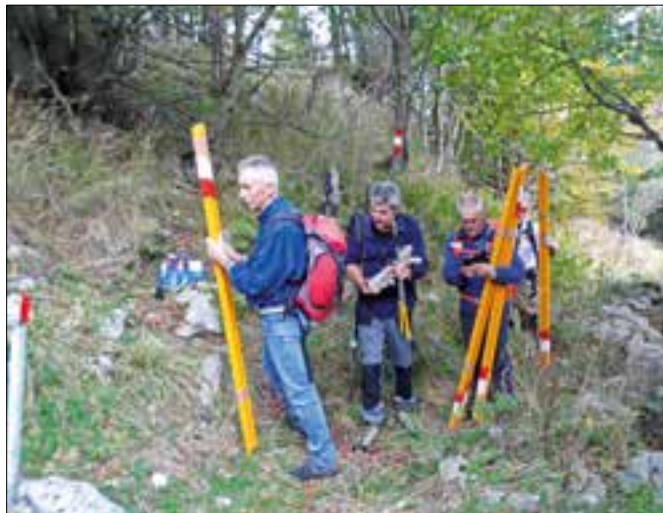
Manutenzione sentiero CAI 763 - Alta via CAI Gemona
